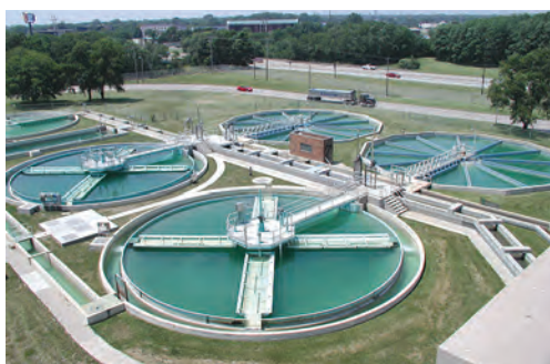
تصفیه آب در تصفیه خانه
