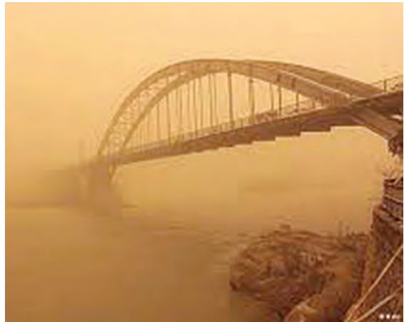
شکل ۳- الف) آلودگی ناشی از ریزگردها- اهواز
